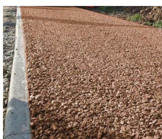
Pavimentazione esterna calcestruzzo drenante tipo Drain Beton
