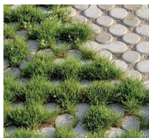
Pavimentazione stalli auto in masselli autobloccanti filtranti rinverditi
