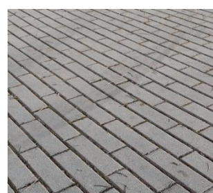
Pavimentazione piazza in masselli autobloccanti
